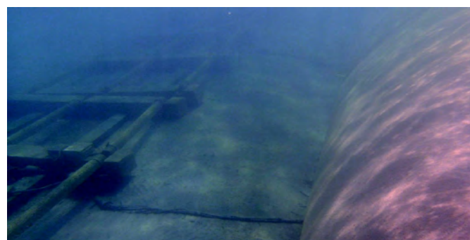
Prototype de brise lame immergé connecté au dispositif développé par GEOCORAIL SAS
