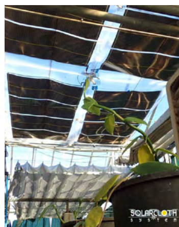
Ecran d'occultation photovoltaïque pour serres
